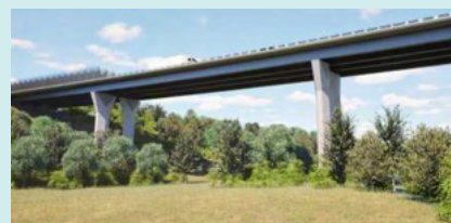
Vue de viaduc à piles hautes
